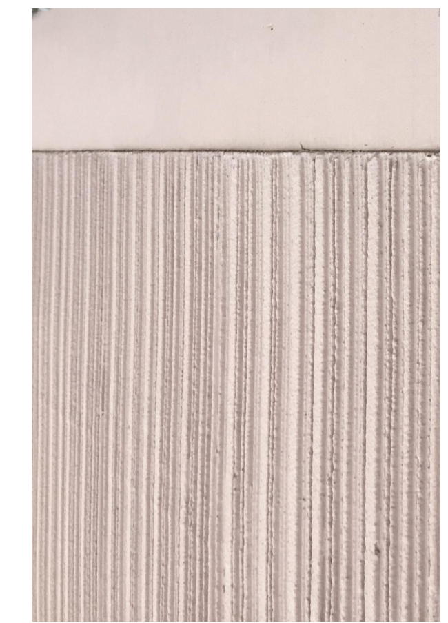
Übergang Fassade - Dach
